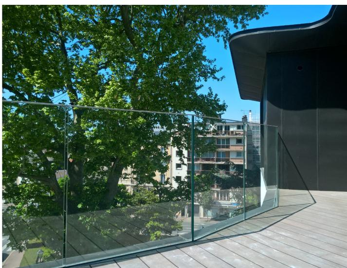
Perçage et fixation sur le nez de la dalle. Il résiste aux charges linéaires d'1 kN et réceptionne un **verre feuilleté trempé 10.10/4** pour des chantiers sous avis technique !
