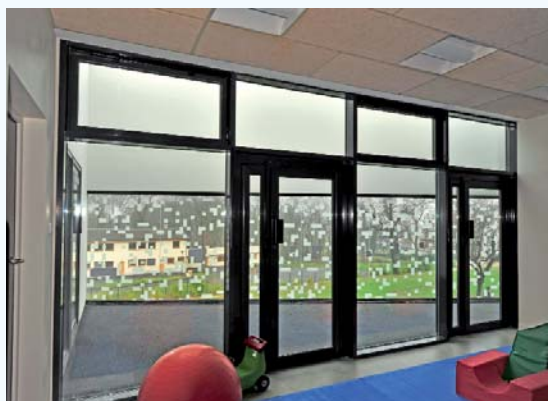
La façade vitrée de l'espace de jeux et la cour triangulaire des petits
